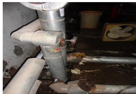
Figura 4: Ocorrência de vazamento de amônia em frigorífico em Senador Canedo-GO. Fonte: Wanderley Valério de Oliveira por meio de guarnições do CBMGO.
