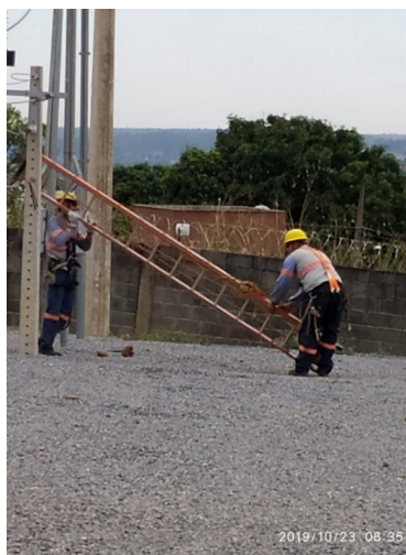
Figura 2: Eletricista de redes, movimentação de escada.
