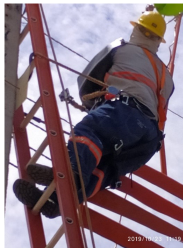
Figura 1: Eletricista de redes, instalação de aterramento.
